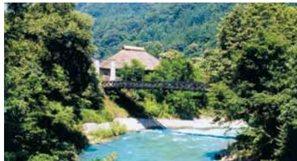
大出吊橋 (E-4)
